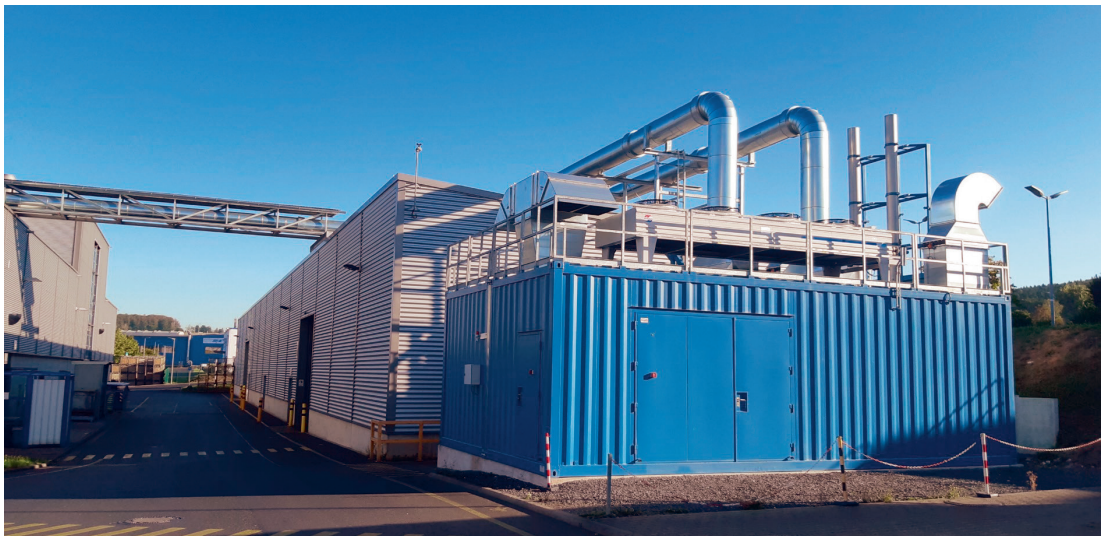
Abb. 10 Doppel-BHKW in Containeraufstellung mit Heißluftverrohrung
