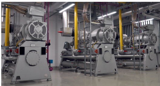
Abb. 1 \text{NH}_3 -Kältemaschine (l.) eines Salzbeckens (r.) (DMK Group, VDI 2021)
