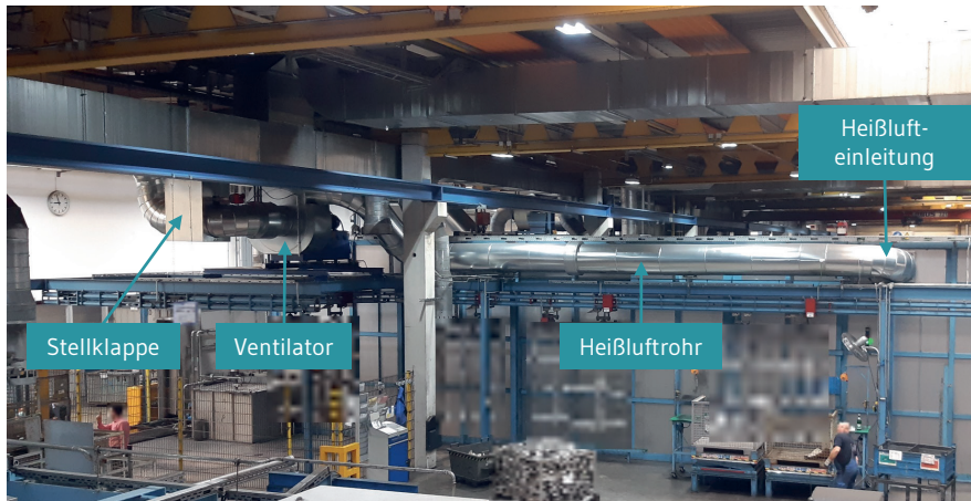
Abb. 11 Bivalenter Wärmebehandlungsofen
